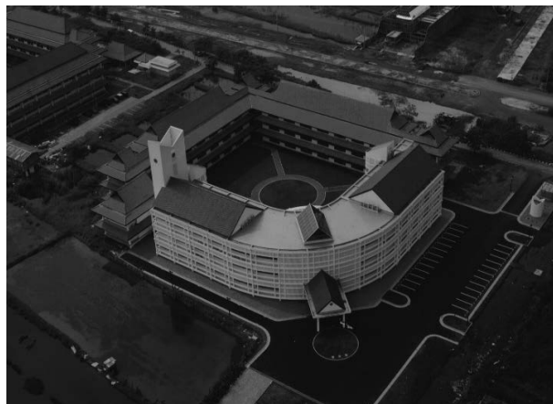
図8 熱帯病センター 鳥瞰図 ■ 1995年11月 基本設計調査 ■ 1997年3月 完成
