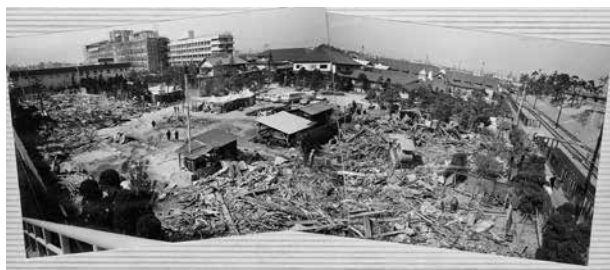
写真10 解体された武庫川病院など
