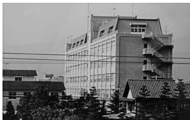
写真6 完成した5号館(昭和46年5月29日完成)
