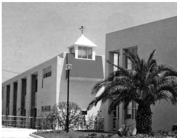
図5 (グラビア10) 武庫川脳病院のシンボルを受け継いだ大村病院東棟
